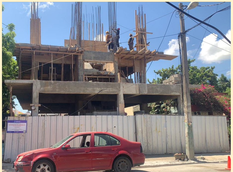
PROYECTO EN EJECUCION
